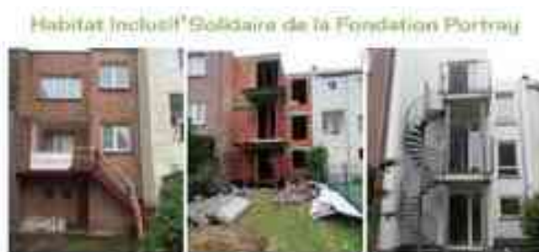
Rue Génot - façade arrière
