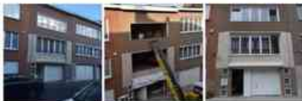
Rue Génot - façade avant Avant, pendant et après rénovation
